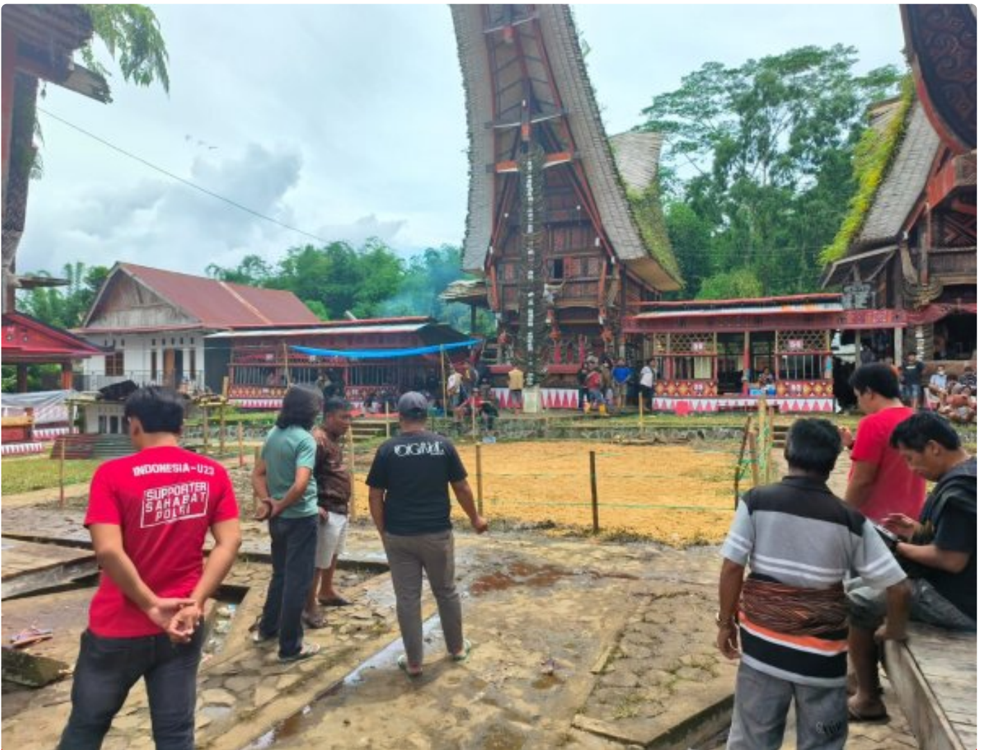
Pembongkaran Arena Judi Sabung Ayam di Sangalla
